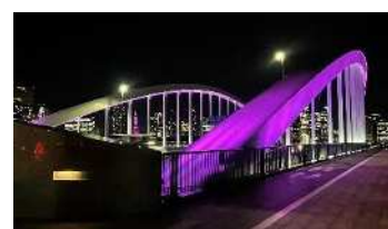
↑ 隅田川橋梁群（築地大橋） ※イメージ
